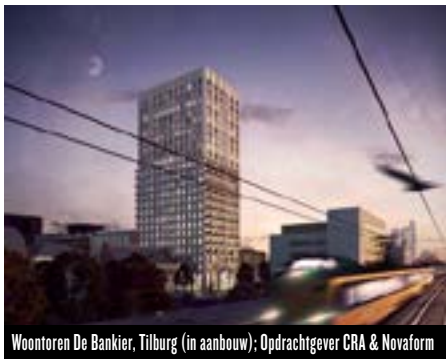
Woontoren De Bankier, Tilburg (in aanbouw); Opdrachtgever CRA & Novaform
