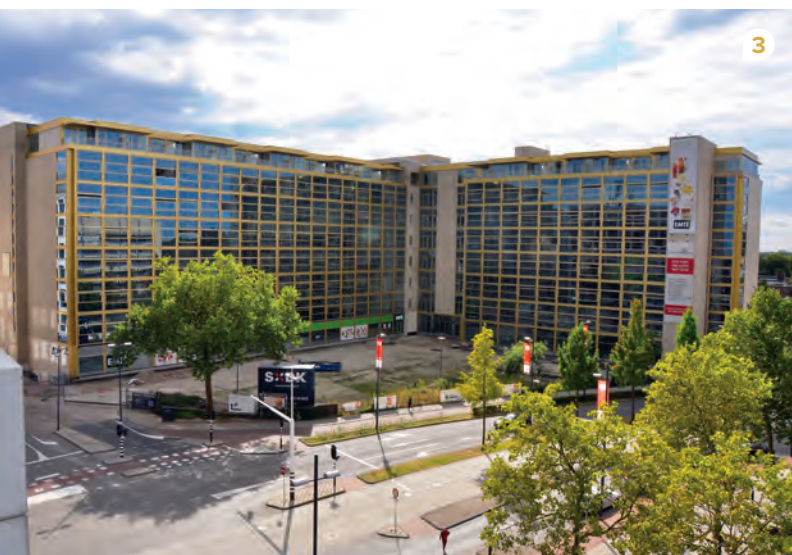
1 // Het gebouw Philips Lighting in oorspronkelijke staat, met gevels van prefab elementen van gewassen grindbeton. 2 // Bij het strippen van het gebouw is alleen het betonskelet overeind gebleven. (Foto: Arthur Bagen) 3 // Iedere loft heeft een goudkleurig geanodiseerd aluminium gevelkozijn gekregen met een schuifraam. De penthouses hebben een terugliggende gevel met voorlangs lopende balkons en afwijkende kozijnen.
