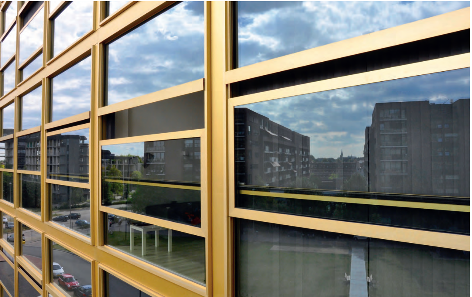
De aluminium kozijnen hebben een verticaal, naar beneden schuivend raamdeel, dat in geopende stand een balustrade vormt en het effect geeft van een inpandig, kamerbreed balkon.
