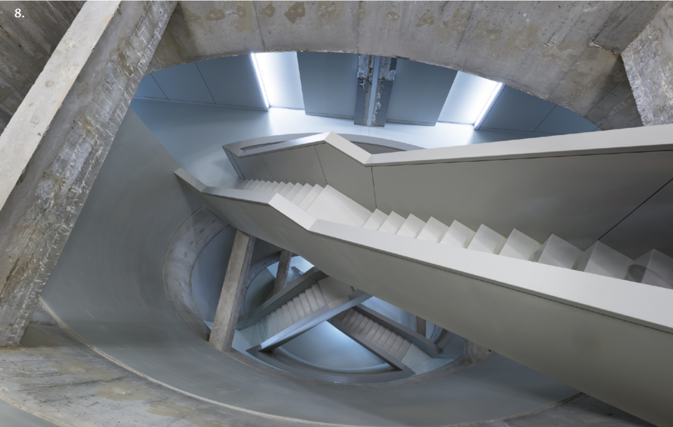
7. Om de belasting van de verwijderde vloerbalken ter plaatse van de sparingen op te vangen, zijn ellipsvormige betonnen ringbalken aangebracht. 8. Speelse doorkijkjes ontstaan door de ellipsvormige vides met daarin rechte steektrappen.
