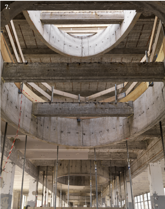
7. Om de belasting van de verwijderde vloerbalken ter plaatse van de sparingen op te vangen, zijn ellipsvormige betonnen ringbalken aangebracht. 8. Speelse doorkijkjes ontstaan door de ellipsvormige vides met daarin rechte steektrappen.
