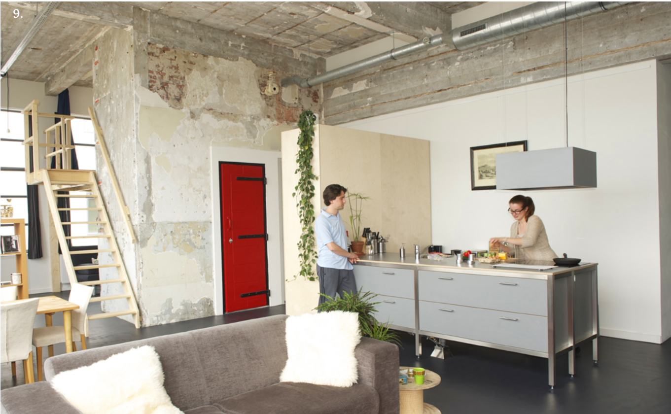
9. De houten latjes die aan de onderzijde van de betonnen vloer zijn ingestort, om bijvoorbeeld lampen aan op te hangen, stammen nog uit de fabrieksperiode. Foto: Hildegard Hick Architecten / www.hickfotografie.nl
