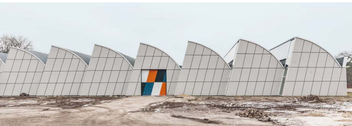
Acht aaneengeschaalde hallen met gebogen zaagtanddaken
