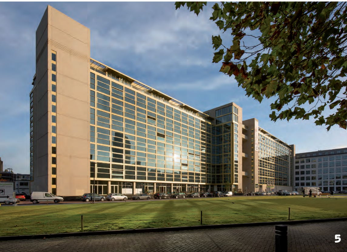
5. Gevel vanuit het zuidwesten. In de traptorens is het originele grindbeton schoongemaakt en behouden. Nieuwe dichte gevels zijn bekleed met travertin, de rest van de gevels bestaat uit aluminium schuifpuien. 6. Kruispunt van de drie vleugels aan de zuidkant. Tussen de twee torens in het midden is per twee verdiepingen een gemeenschappelijke ruimte met groot balkon gemaakt. • Foto's Jan Willem Schouten.
